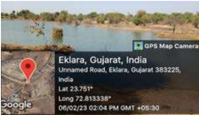
GP : Eklara Structure : Percolation Pond
