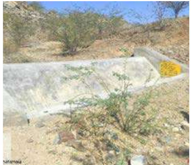
GP : Khatamala Structure : Check Dam
