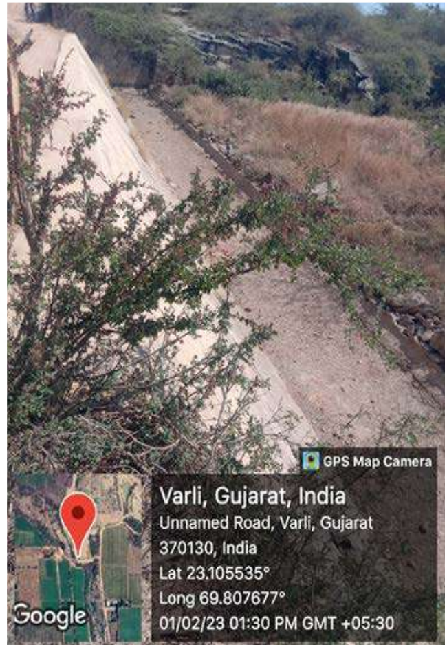
GP : Varli Structure : Check Dam
